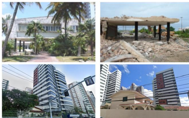
Figura 3: Fotos da Casa antes da demolição, em processo de demolição, do prédio e de uma casa vizinha.
