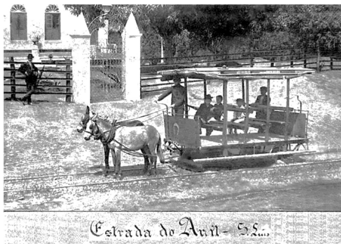
Figura 1: Bonde na Estrada do Anil. Fonte: Morrison (2011).
