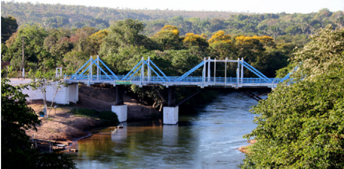
Figura 29 – Principal ponte em Ponte Alta do Tocantins (TO)
